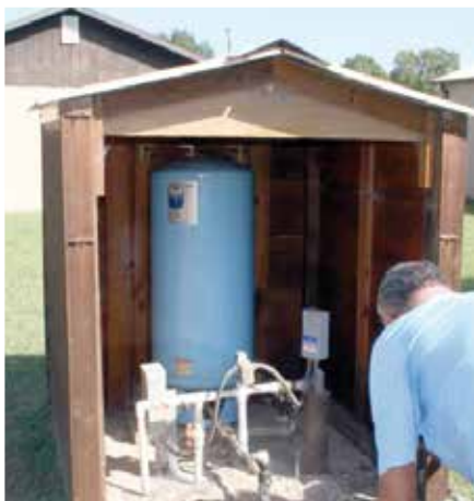
Système d'approvisionnement en eau de forage domestique
