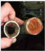
Sistema de tuberías
