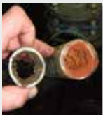
Sistema de tuberías
