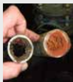
Sistema de tuberías
