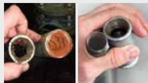
Sistema de tuberías
