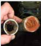
Sistema de tuberías
