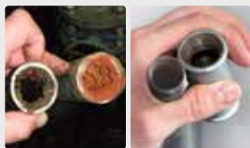
Sistema de tuberías
