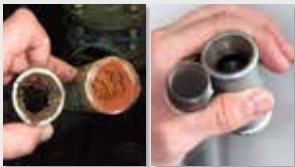
Sistema de tuberías
